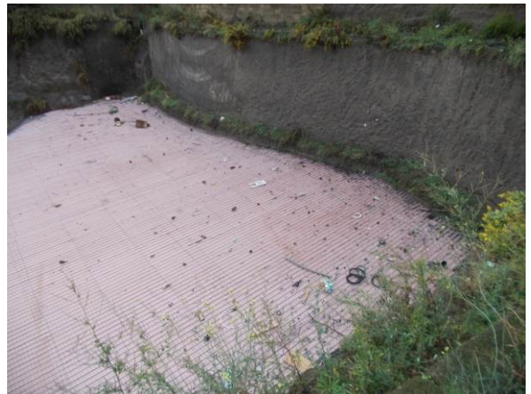
Figg. 17-18: copertura di Villa dei Papiri: si noti il punto in cui la copertura ha ceduto a causa di uno smottamento avvenuto nel 2015 (archivio Studio Pesaresi per HCP – 2015)
