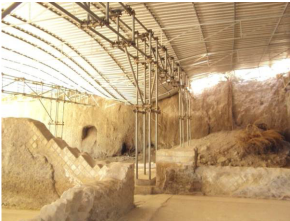
Figg. 17-18: copertura di Villa dei Papiri: si noti il punto in cui la copertura ha ceduto a causa di uno smottamento avvenuto nel 2015 (archivio Studio Pesaresi per HCP – 2015)
