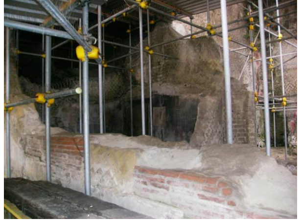
Figg. 7 - 8: la visibilità delle strutture archeologiche è compromessa a causa dell'altezza e delle strutture portanti delle coperture provvisorie (archivio Studio Pesaresi per HCP – 2013)
