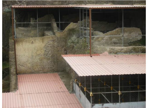
Figg. 21-22: il sistema di raccolta delle acque piovane, costituito da gronde e pluviali in plastica, non convoglia le stesse in adeguate canalizzazioni (archivio Studio Pesaresi per HCP – 2015)
