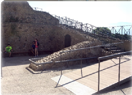
Fig. 29: Parco Archeologico di Pompei. Antiquarium e Villa Imperiale. Elementi metallici reversibili con piano di calpestio in doghe di legno tecnico.
